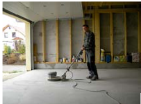
1. Vorbereitung des Untergrundes
