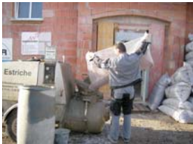
3. Verarbeiten des Leichtestriches
