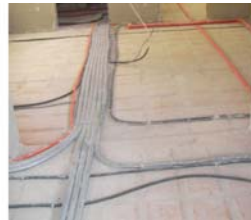
2. Ziegeldecke mit Leitungen
