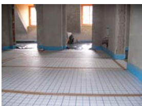
7. Fertige Dämmung
