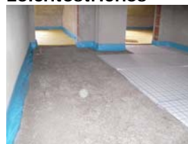
6. Dämmung auf Leichtestrich
