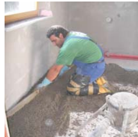
4. Einbau des Leichtestriches
