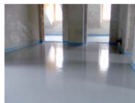
8. Eingebauter Fließestrich
