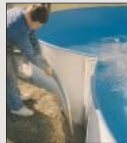
Schwimmbecken-Hinterfüllung
