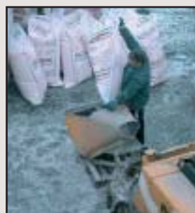
Mischung mit Estrichpumpe
