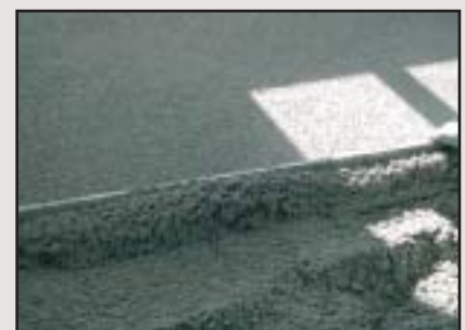
Einbau mit Abziehlatte
