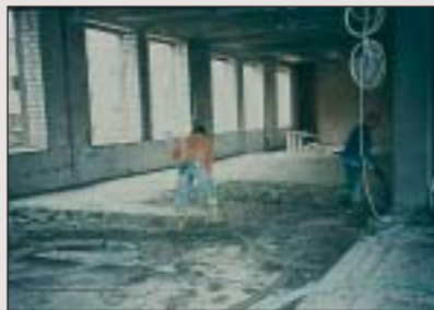
Ausgleichen alter Deckenkonstruktionen
