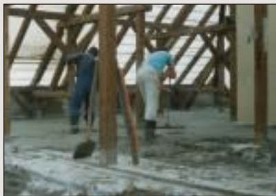
Dachisolierung
